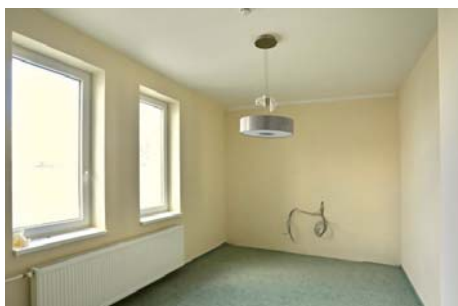
Pokoje v bytovací části A jsou vymalovány, jsou v nich položeny koberce, instalovány nové radiátory...
