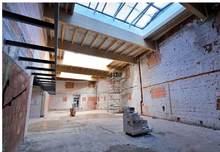
Pohled z budoucí jídelny k vysokému stropu, kde jsou instalovány tři velké střešní světlíky. V těchto místech býval dvůr.
