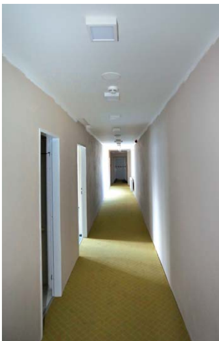
Nové koberce jsou položeny i na chodbách. Ve stropě jsou osazena nová světla, požární čidla a klimatizace.
